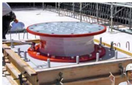
地震の揺れによる倒壊を防ぐ免震装置
